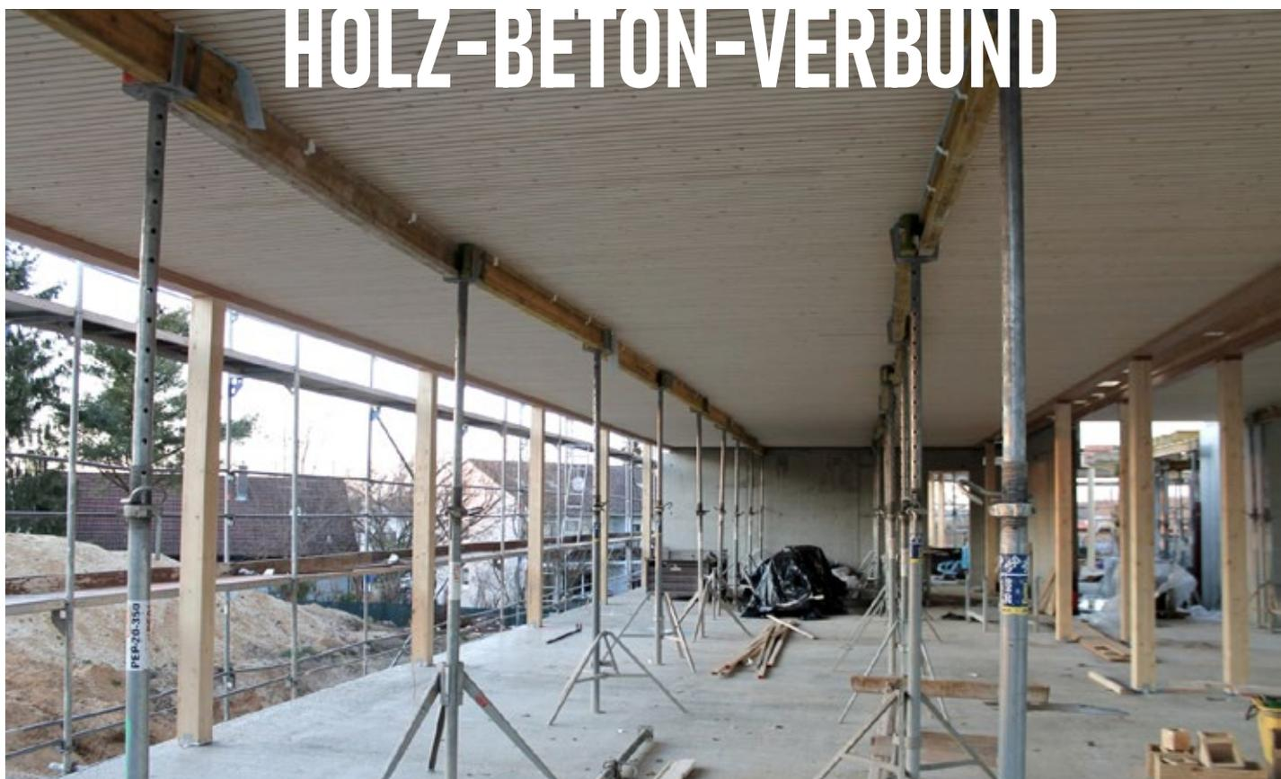
Vor dem Betonieren wird die Decke leicht überhöht – so kann die Anfangsdurchbiegung der Decke durch ihr Eigengewicht ausgeglichen und die spätere Verformung reduziert werden.
